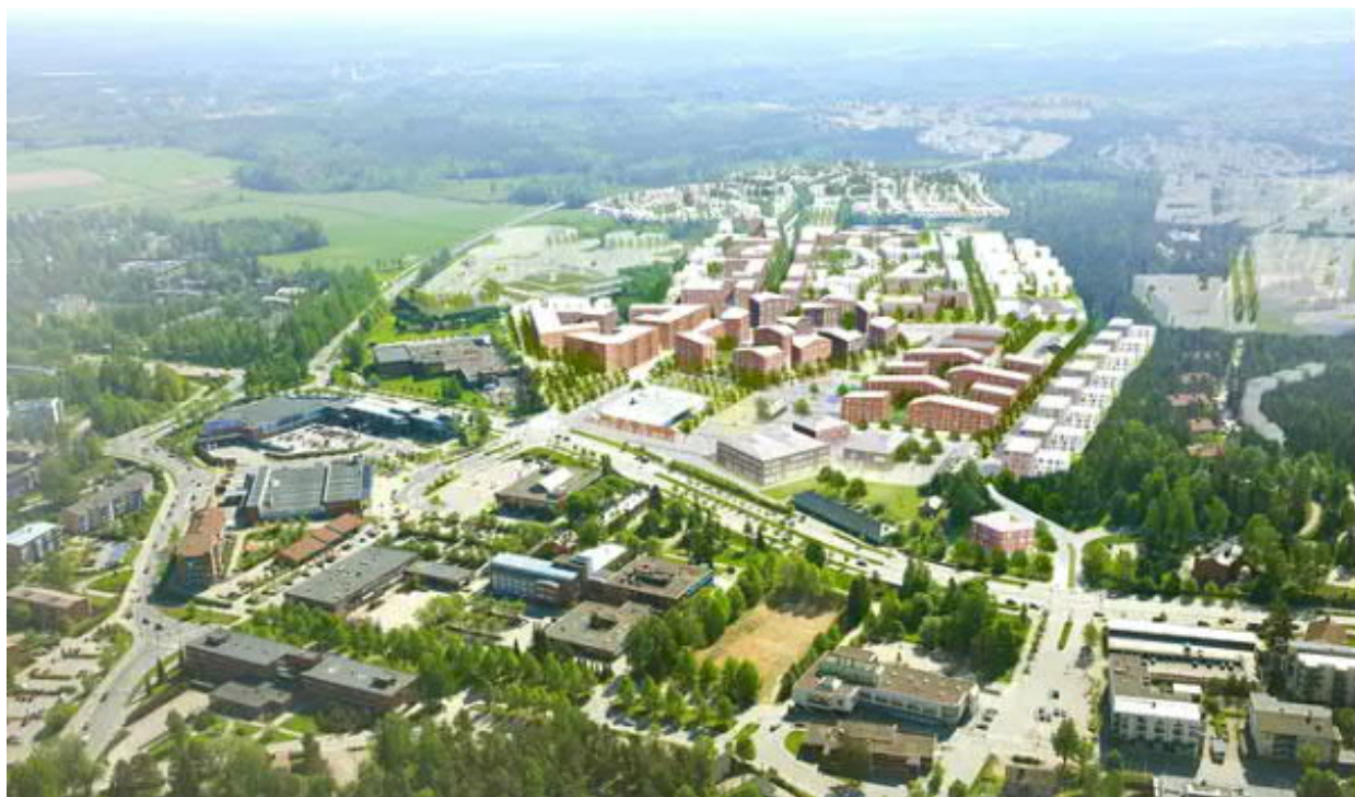
Kuva 14. Rykmentinpuisto laajentaa Hyrylän kuntakeskuksen tavoitteena vahvistaa keskusta seudullisessa verkossa. Alueelle tulee sijoittumaan erityisesti lisää palvelualan yrityksiä.
